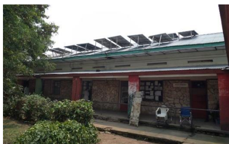
5. Panneaux photovoltaïque, Kabinda, 2008.
